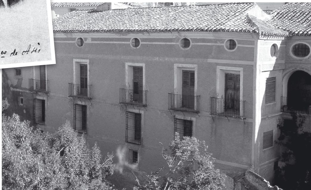
■ Casa de los Arcos en Vélez Blanco, residencia de los Torrente Villena.
